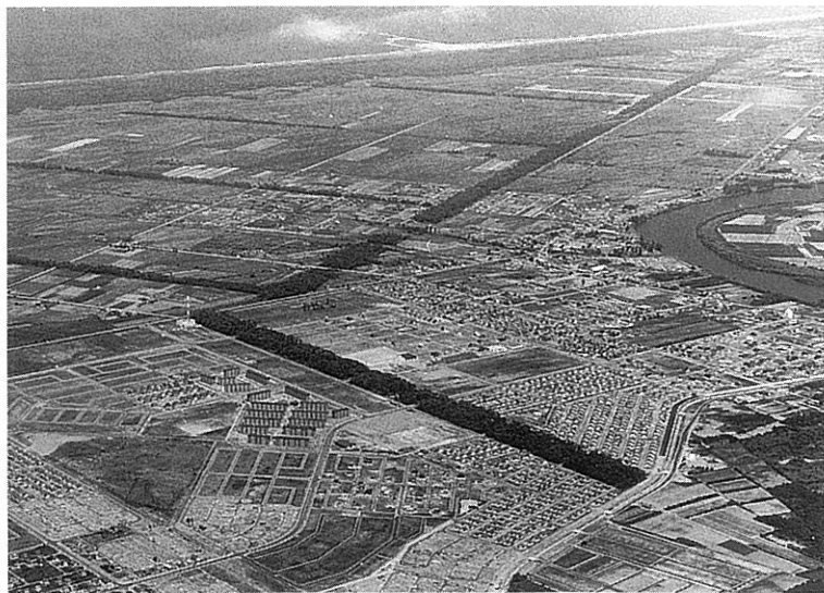
花畔団地空撮／昭和50年頃／北海道住宅供給公社所蔵資料
