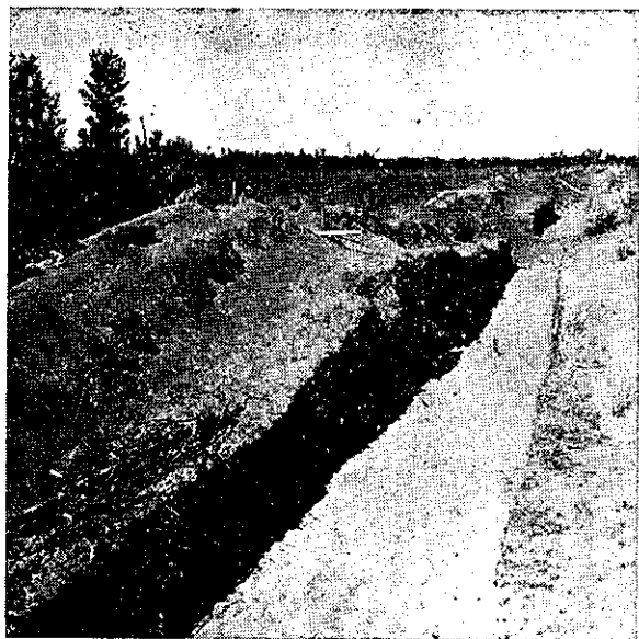
第4図 聚富川沿いの排水溝工事現場（遺跡番号18）
